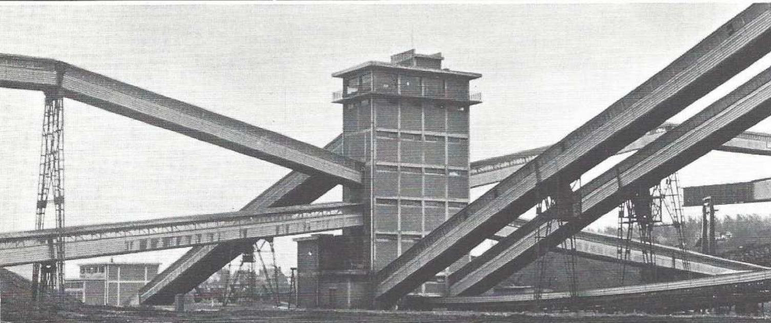
▲ Tour de jonction des différents convoyeurs à charbon
