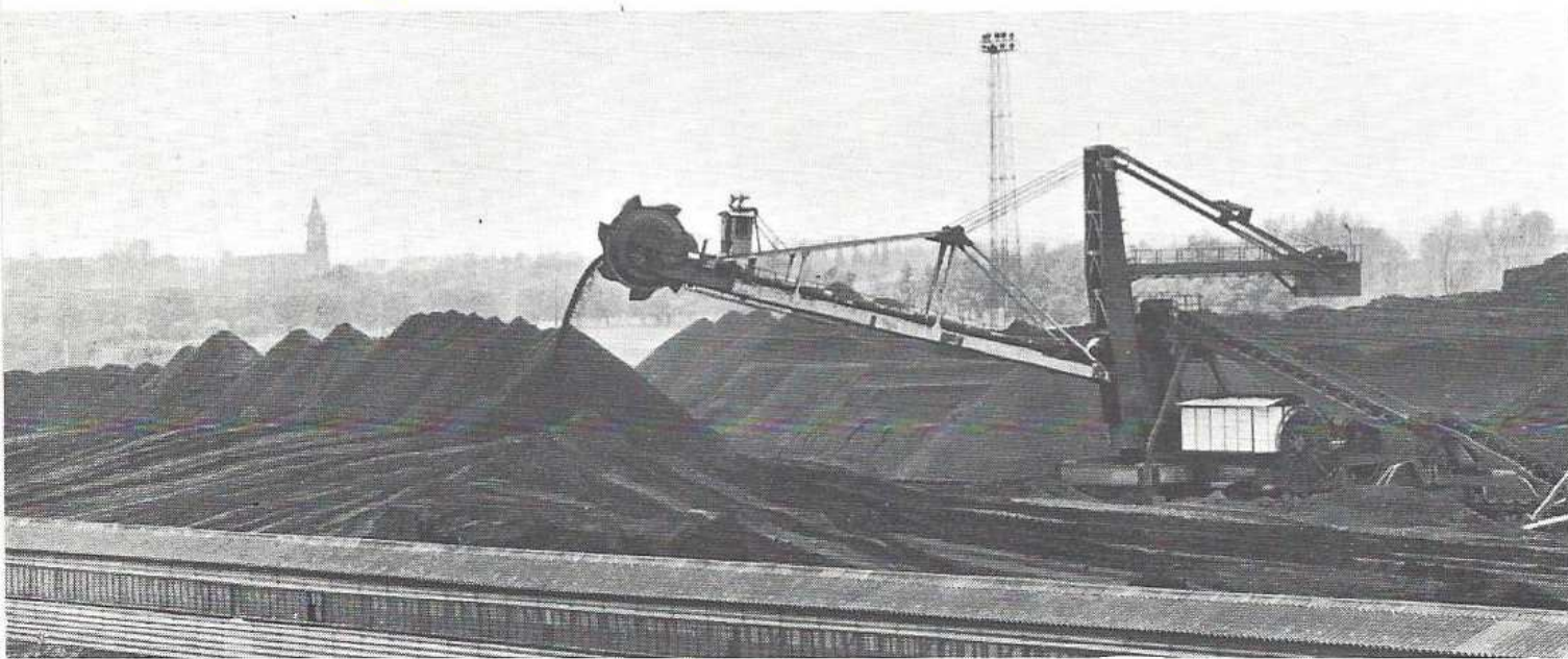
▲ Engin mobile de mise en parc et de reprise du charbon
